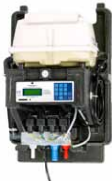
Armoire de commande PPE ouverte (Art. : 35248 - vendue séparément)
